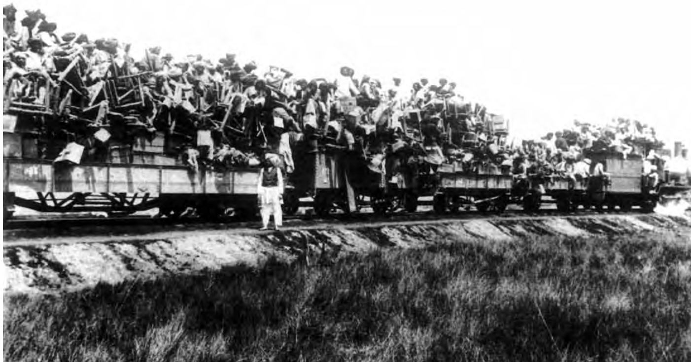
FIGURA 7.2 Equipe volante de assentadores de dormentes na construção da estrada de ferro de Uganda. (Fonte: Royal Commonwealth Society.)
